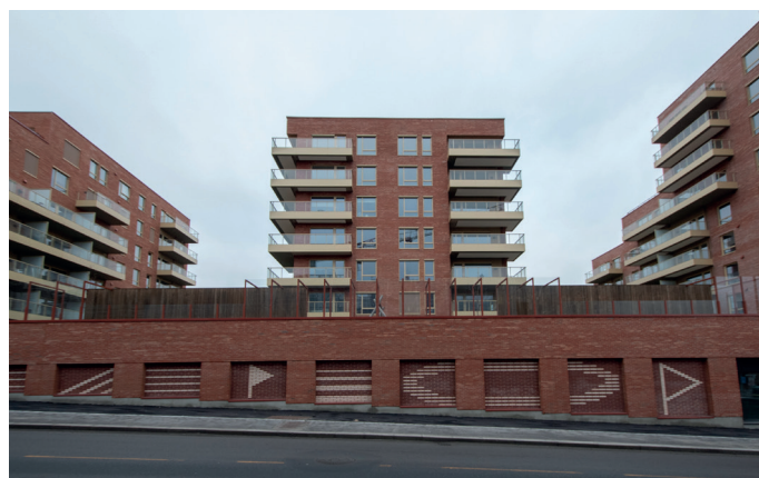
Murvegger og støyskjermer skjærer boligene fra trafikken.
